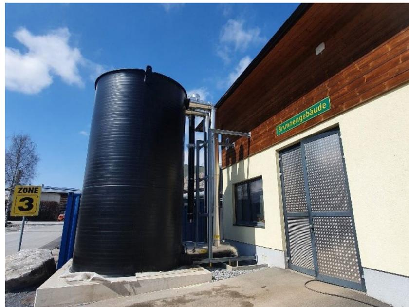
Abb. 19: Druckfliteranlage zur Enteisung und Entmanganung
